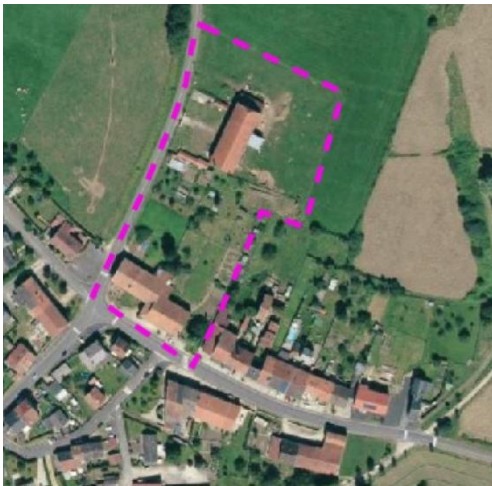
Exemple de densification de ferme à Vrigne-Meuse Projets potentiels : « La possibilité d’une densification en fond de parcelle »
