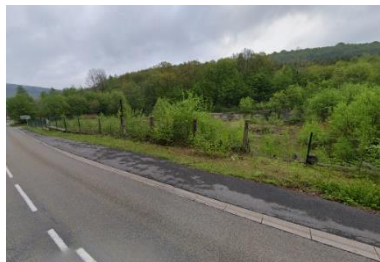
Figure 4.49 Exemple d'une friche située hors enveloppe urbaine : ancienne fonderie à Deville (parcelle : 7 947 m 2 / surface bâtie : 0 m 2 ) coûts de renaturation complète 1 estimés : 754 965 € à 3 099 330 € (Google street view)
