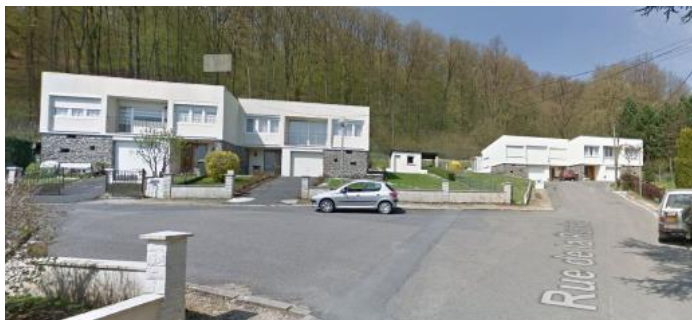
Figure 4.40 Maisons jumelées ou groupées à Vrigne-aux-Bois (source Google street view)
