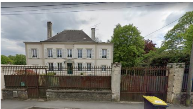
Figure 4.24 Villa urbaine avec son écrin vert à Vrigne-aux-Bois (source Google street view)
